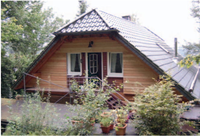
oben links: Die neue Lattung wurde mit sibirischer Lärche ausgeführt
